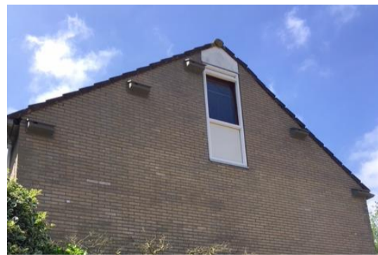
Foto 2: zwaluwkasten aan de zijgevel
